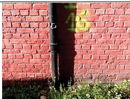
Photo n° PhA016 Localisation : Parties extérieures Ouvrage : Conduit Partie d'ouvrage : Conduit fibro ciment Description : Conduit de ventilation
